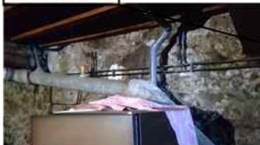
Conduit de fluide A Amiante ciment
